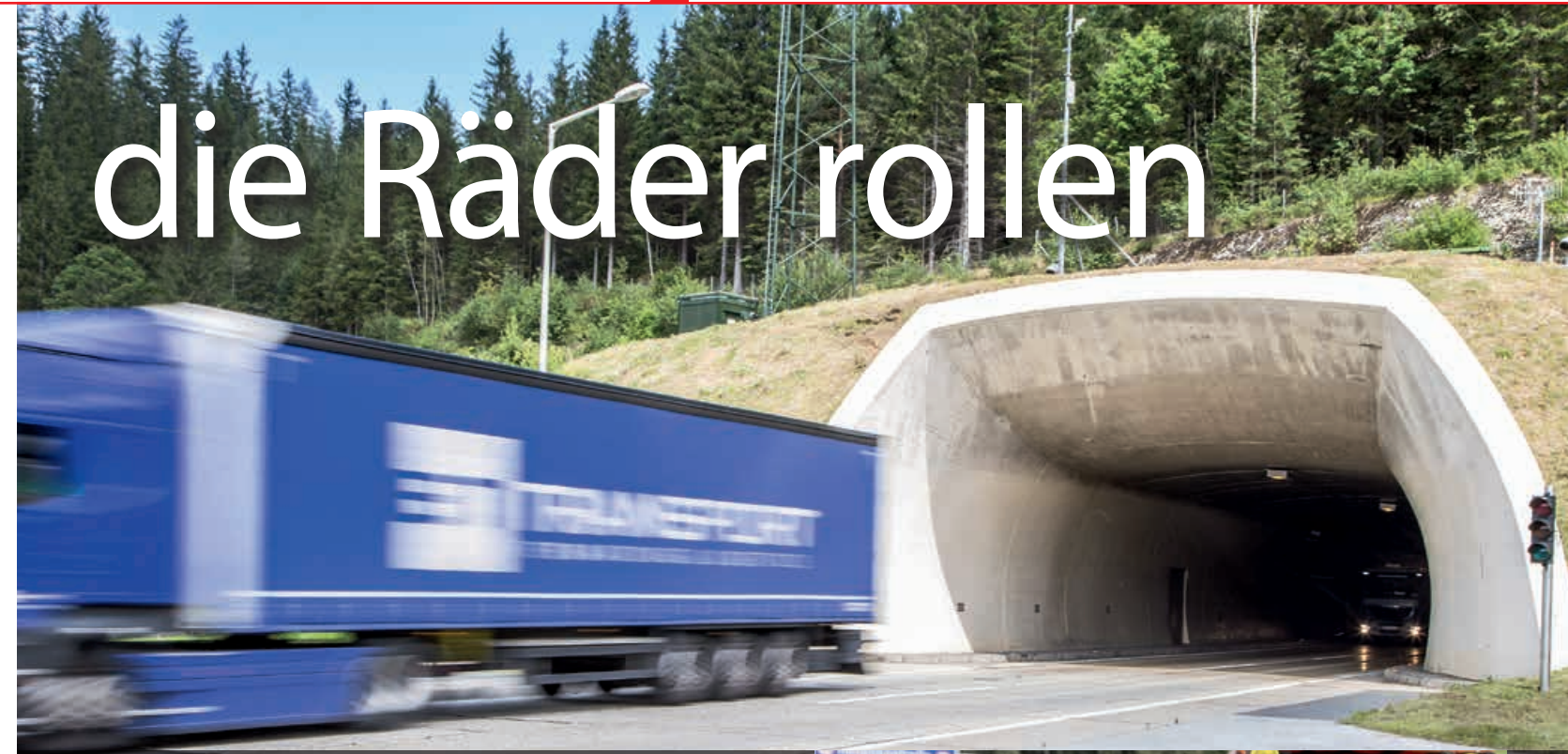
Die Autobahnmeisterei auf der steirischen Seite der Pack betreut 31 Kilometer Straße mit vier Tunnel und 45 Brücken. Bevor die Straßenmaler ans Werk gehen können, muss umfangreich abgesichert werden.
